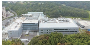
新・三田工場竣工(2020年)
