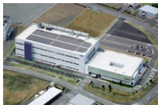
熊本県合志市に九州工場竣工(2004年)
