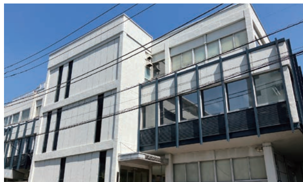
タンケンシールセーコウ本社工場
