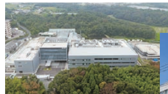
新・三田工場竣工（2020年）
