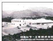
兵庫県三田市に三田工場が竣工 (1967年)
