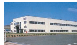
京都府福知山市に福知山工場(現 福知山事業所第1工場)竣工(1989年)
