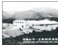
兵庫県三田市に三田工場竣工(1967年)
