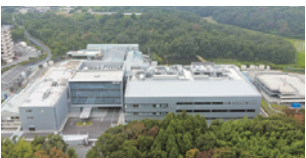
新・三田工場竣工（2020年）
