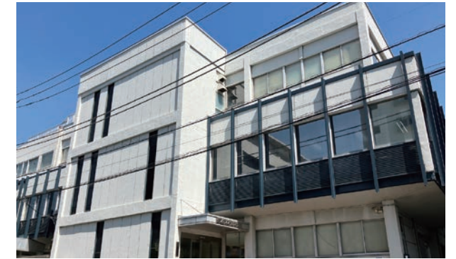
タンケンシールセーコウ本社工場
