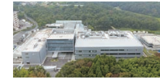
新・三田工場竣工(2020年)
