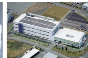
熊本県合志市に九州工場竣工(2004年)
