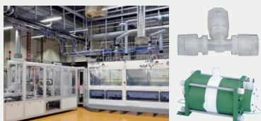
サーキュレーション
