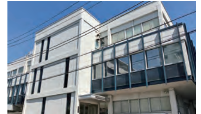
タンケンシールセーコウ本社工場
