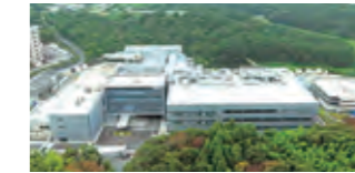
新・三田工場竣工(2020年)
