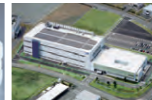
熊本県合志市に九州工場竣工(2004年)
