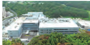
新・三田工場竣工(2020年)
