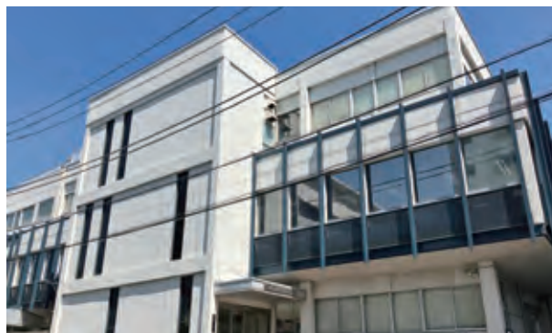
タンケンシールセーコウ本社工場
