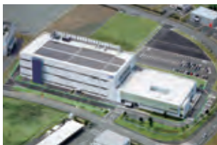
熊本県合志市に九州工場竣工(2004年)
