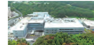
新・三田工場竣工(2020年)
