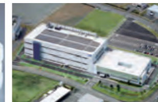
熊本県合志市に九州工場竣工(2004年)
