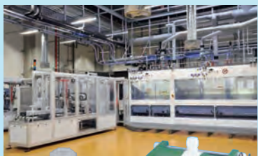
サーキュレーション
