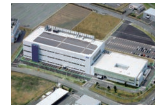
熊本県合志市に九州工場を竣工 （2004年）
