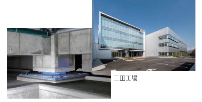
免震装置・スライドベアリング
