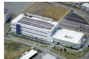
熊本県合志市に九州工場竣工(2004年)
