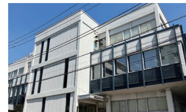
タンケンシールセーコウ本社工場
